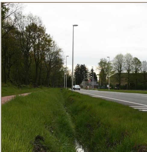
Situering: Liersesteenweg Kessel Project: AWV module 13 Uitvoeringsdatum: 2011 Uitvoerder: AWV
